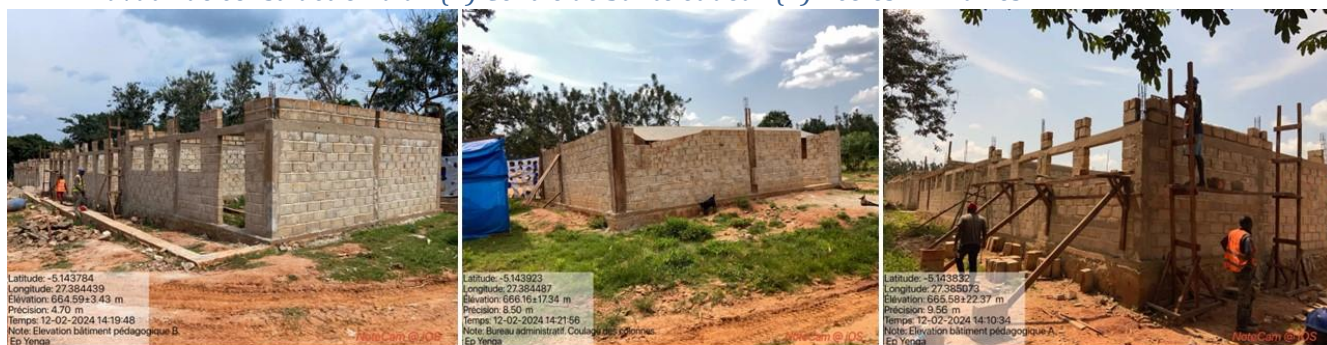
Elévation des murs du bâtiment pédagogique (classes) de l'école primaire YENGA de KONGOLO
